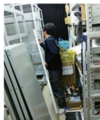
⑤ ラック仕上げ
